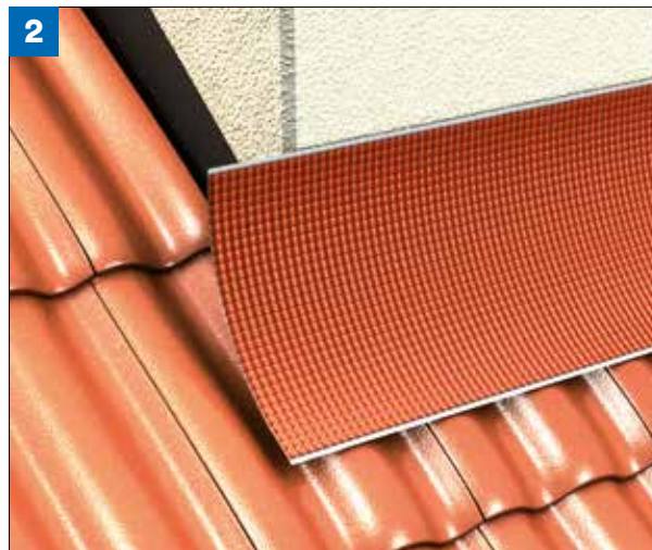
(Bild 2) Eckvariante 1: DELTA®-TOP FLEXX auf beiden Seiten mit ca. 3–5 cm Überstand ablängen.
