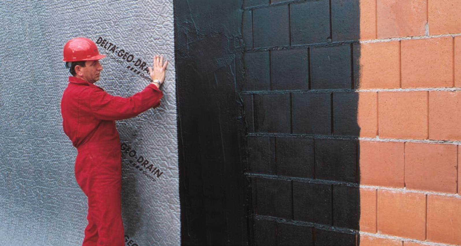
Il sistema di protezione e di drenaggio DELTA®-GEO DRAIN Quattro è posato con il piano di scorrimento (giallo) rivolto verso la muratura ed il non tessuto verso il terreno.
