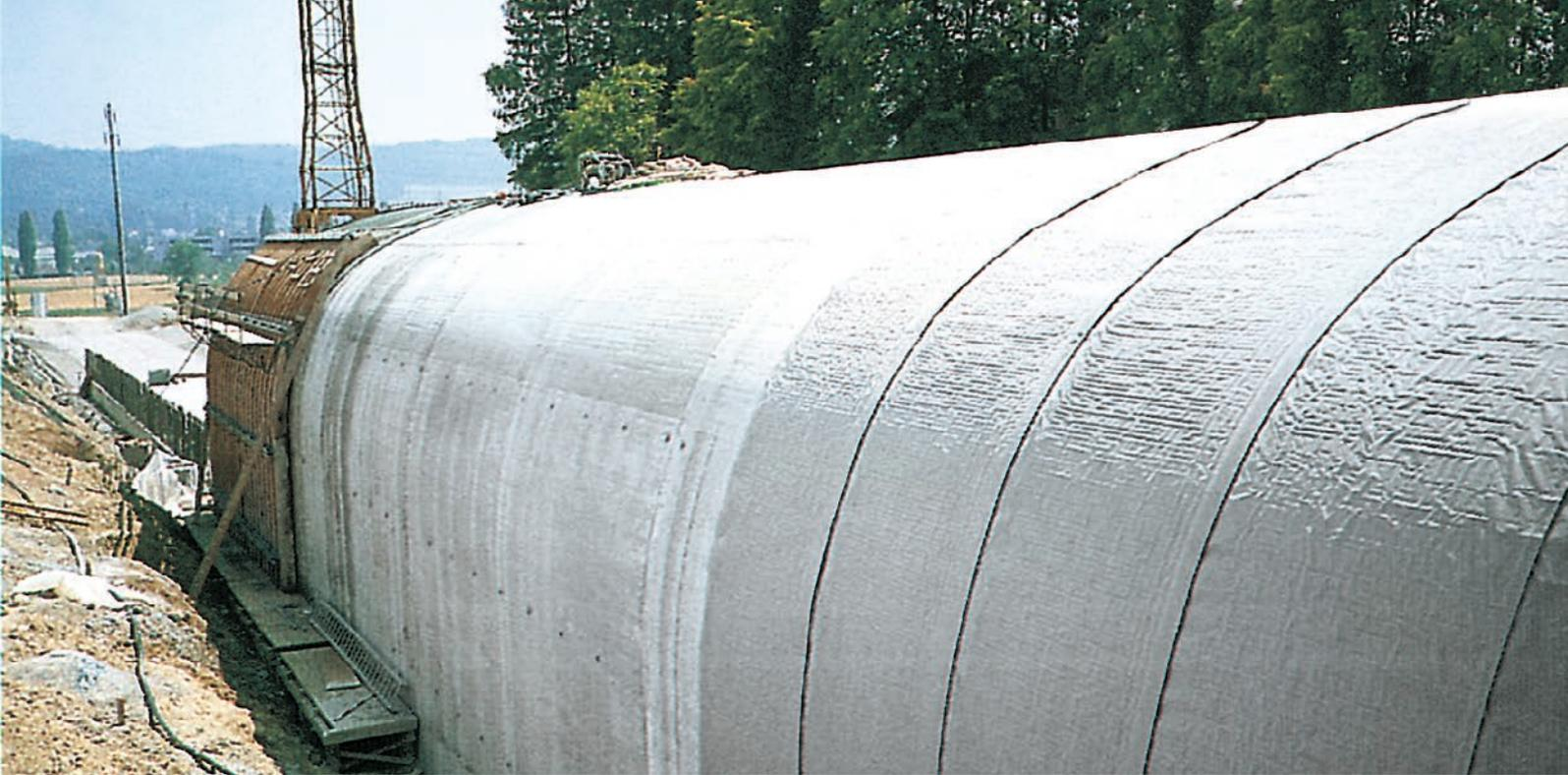
*Trincea coperta. Tunnel costruito a cielo aperto. La posa della membrana alveolare (tipo DELTA®-TERRAXX) sulla superficie esterna della volta, permette di evacuare l'acqua di superficie e di falda. La trincea viene poi interrata con il materiale proveniente in genere dallo scavo stesso. La resistenza a lungo termine alla compressione di DELTA®-TERRAXX è di circa 90 kN/m<sup>2</sup>.*
