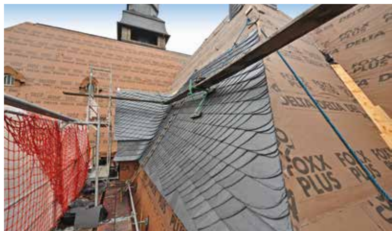
DELTA®-FOXX PLUS jako otwarte dyfuzyjne pokrycie wstępne.
