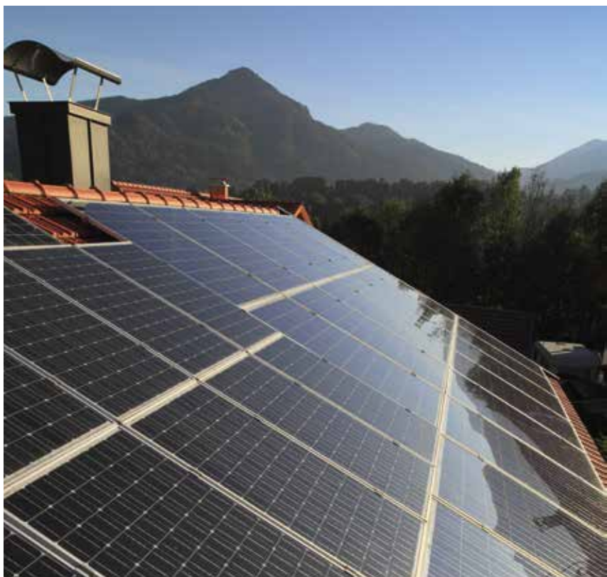
System dachowy jak np. fotowoltaika powoduje wystąpienie podwyższonych wymogów dla dachu.
