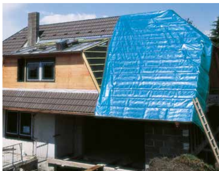
DELTA®-DACHPLANE jako zabezpieczające przed deszczem pokrycie pomocnicze
