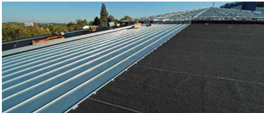
DELTA®-TRELA PLUS jako warstwa rozdzielająca przy pokryciu metalowym.
