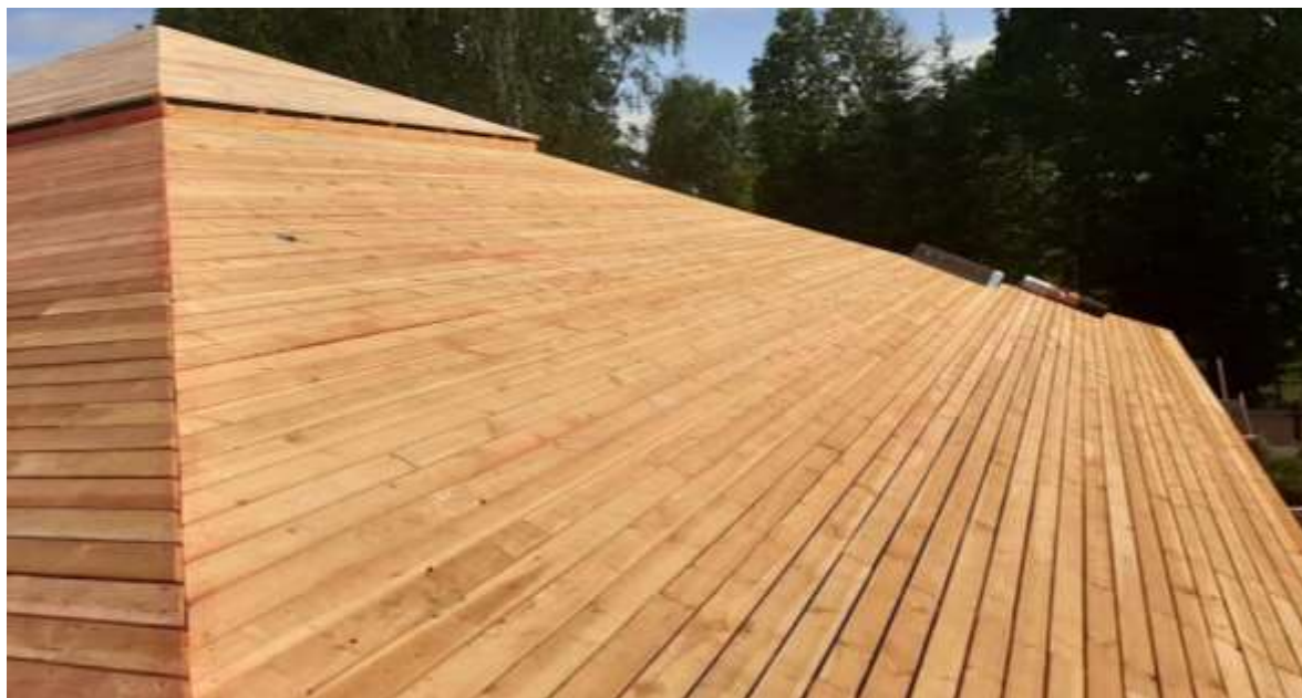
Рис. 3 Сплошной настил под фальцевую кровлю
