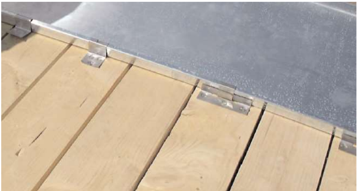
Рис. 2 Монтаж фальцевой кровли по настилу без разделительного слоя
