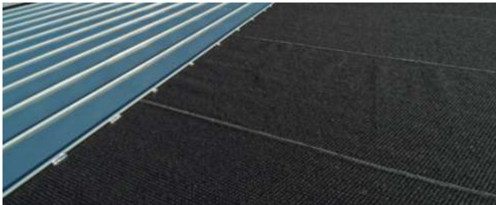
Рис. 5 DELTA-TRELA PLUS разделительный слой (ОДМ)
