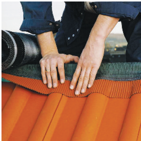
Рис. 3. Плиссированная форма боковых полос из алюминия и самоклеящиеся ленты позволяют выполнить надежное соединение вентиляционного рулона с кровельным покрытием
