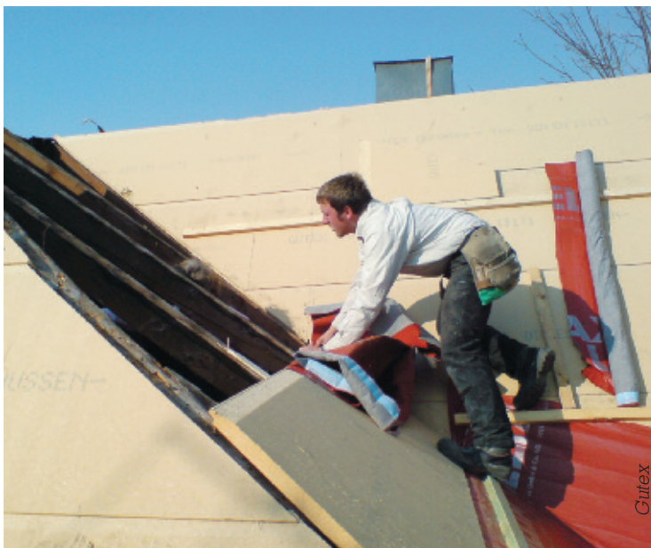
Рис. 4. Реконструкция крыши: утепление древесноволокнистыми плитами с последующей изоляцией диффузионной мембраной
