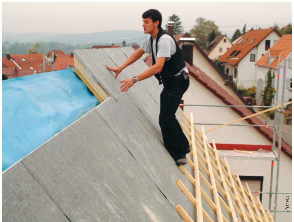
Рис. 2. Утепление плитами из пенополиуретана, кашированного ветрозащитной мембраной
