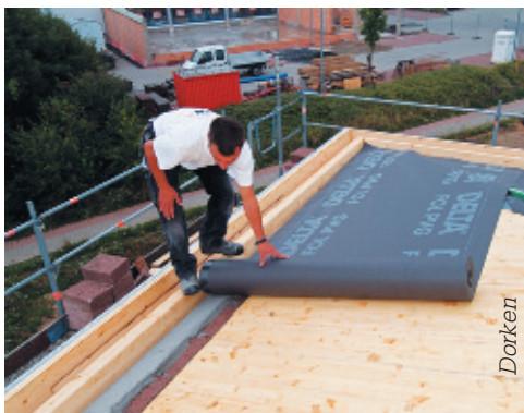
Рис. 5. Начало монтажа пароизоляции на карнизном свесе
