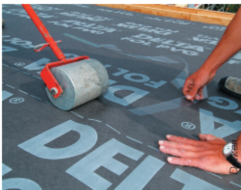
Рис. 7. Уплотнение зоны проклейки рулонов пароизоляции
