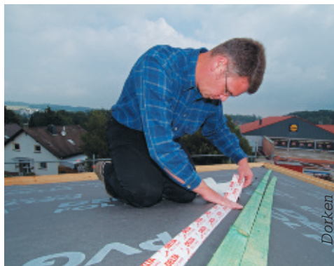
Рис. 8. Применение ленты для проклейки рулонов
