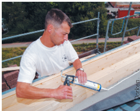
Рис. 6. Проклейка пароизоляции на карнизном свесе
