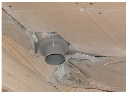
Отсутствует уплотнение в месте вывода вентиляционного канала. Профессиональная манжета для уплотнения проходки
