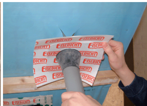
Отсутствует уплотнение в месте вывода вентиляционного канала. Профессиональная манжета для уплотнения проходки
