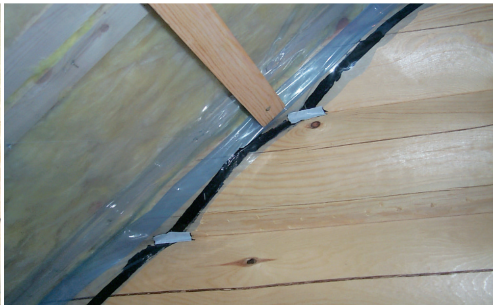
Примыкание к бревенчатой стене двусторонней лентой без прижимной планки
