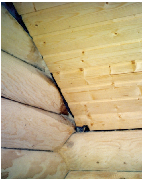
Примыкание к бревенчатой стене двусторонней лентой без прижимной планки
