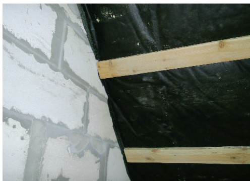
Примыкание к стене без компенсационной складки и без уплотнения
