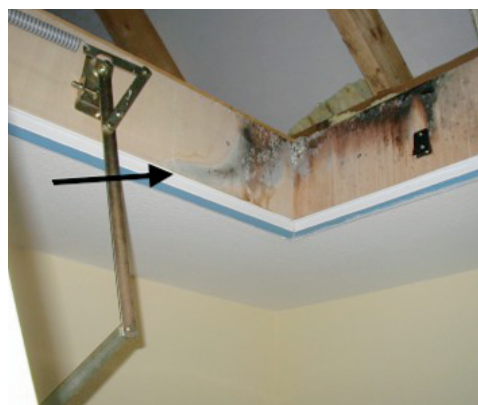
Отсутствует примыкание пароизоляции и утеплителя к мансардному окну
