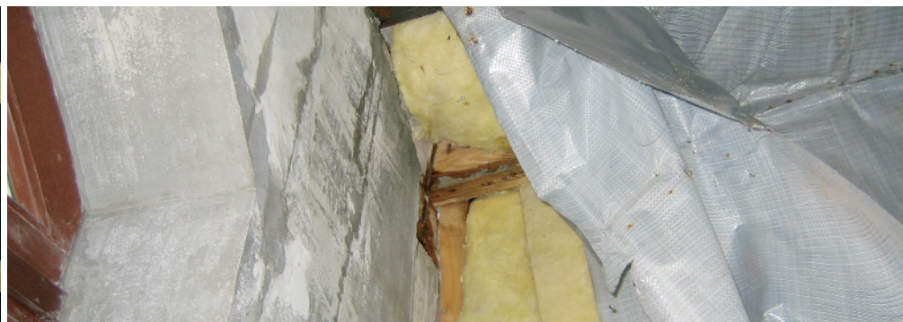
Примыкание к стене без компенсационной складки и без уплотнения
